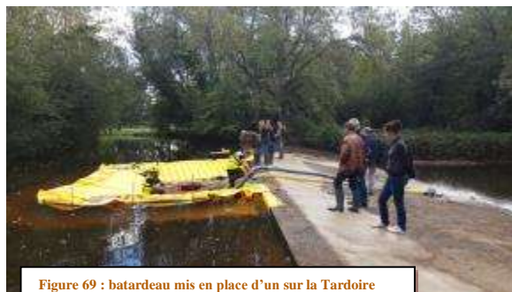
Figure 69 : batardeau mis en place d'un sur la Tardoire
