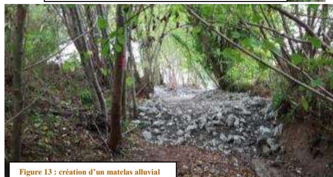
Figure 13 : création d'un matelas alluvial
